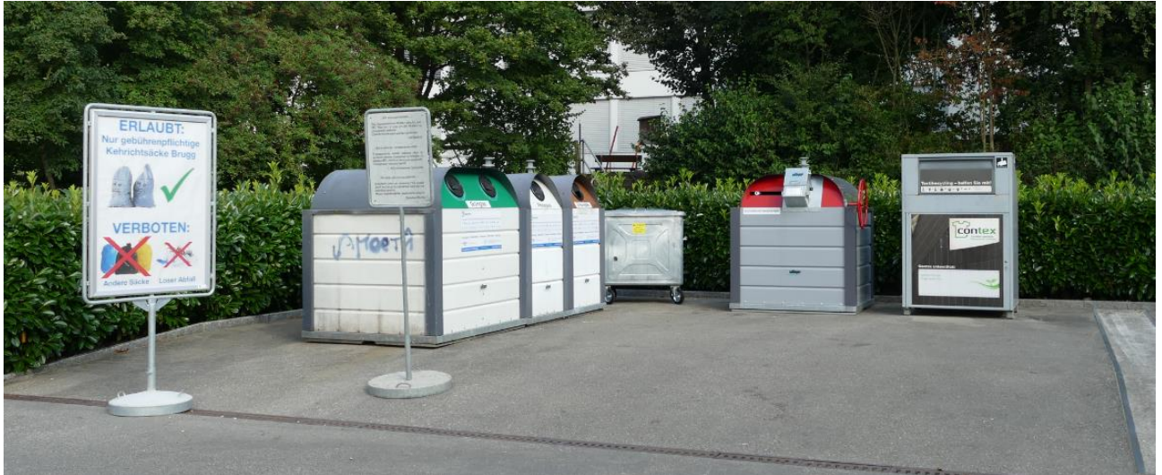
Wertstoffsammelstelle Langmatt Ansicht
