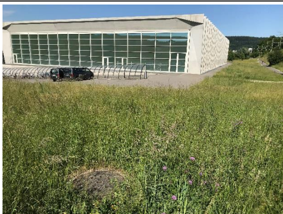
Schacht vor Sportanlage Mühlmatt
