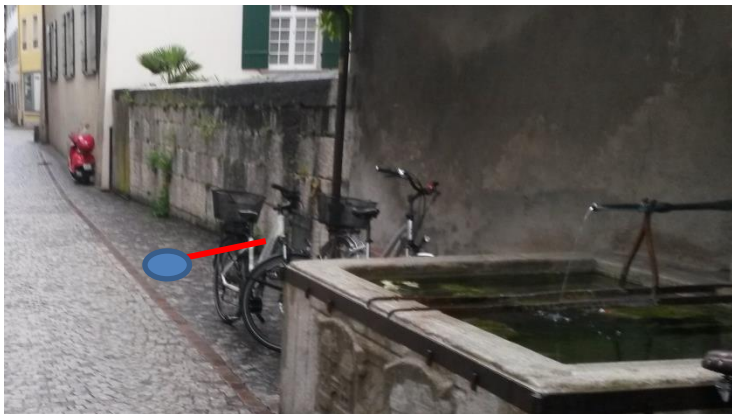
Abbildung 7 Brunnen B14 im Vordergrund. Geplanter KS X mit Leitung von B15 und zu unterquerender Mauer im Hintergrund.
