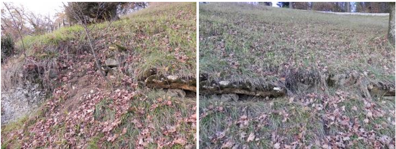
Alte Rebbastrukturen werden wieder gerichtet (Teil des Steinschlagkonzeptes)
