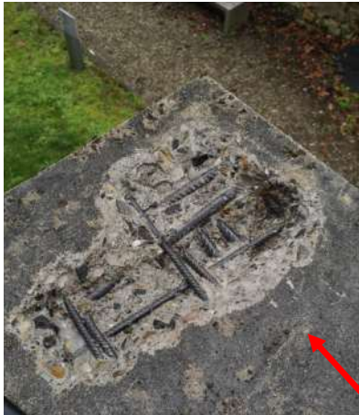
Oben in beide Richtungen am Rand je 3 Eisen Durchmesser 16mm
