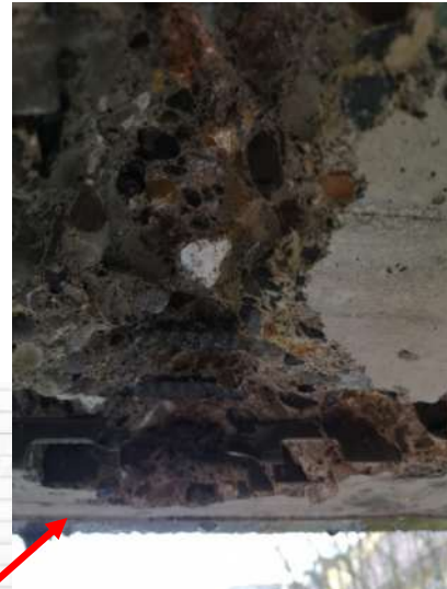
Unten in Bügel 3 Eisen Durchmesser 16mm
