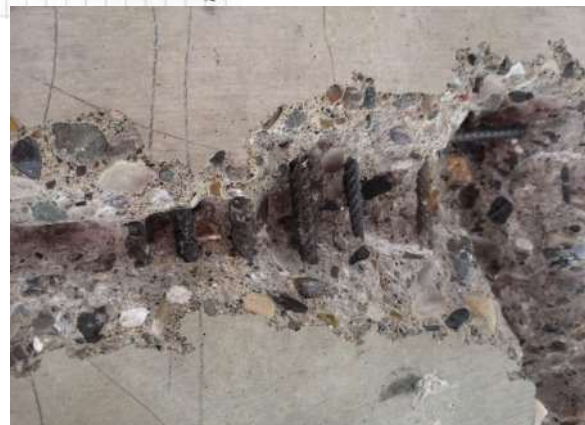
1. Lage 4 Eisen Durchmesser 12mm.
