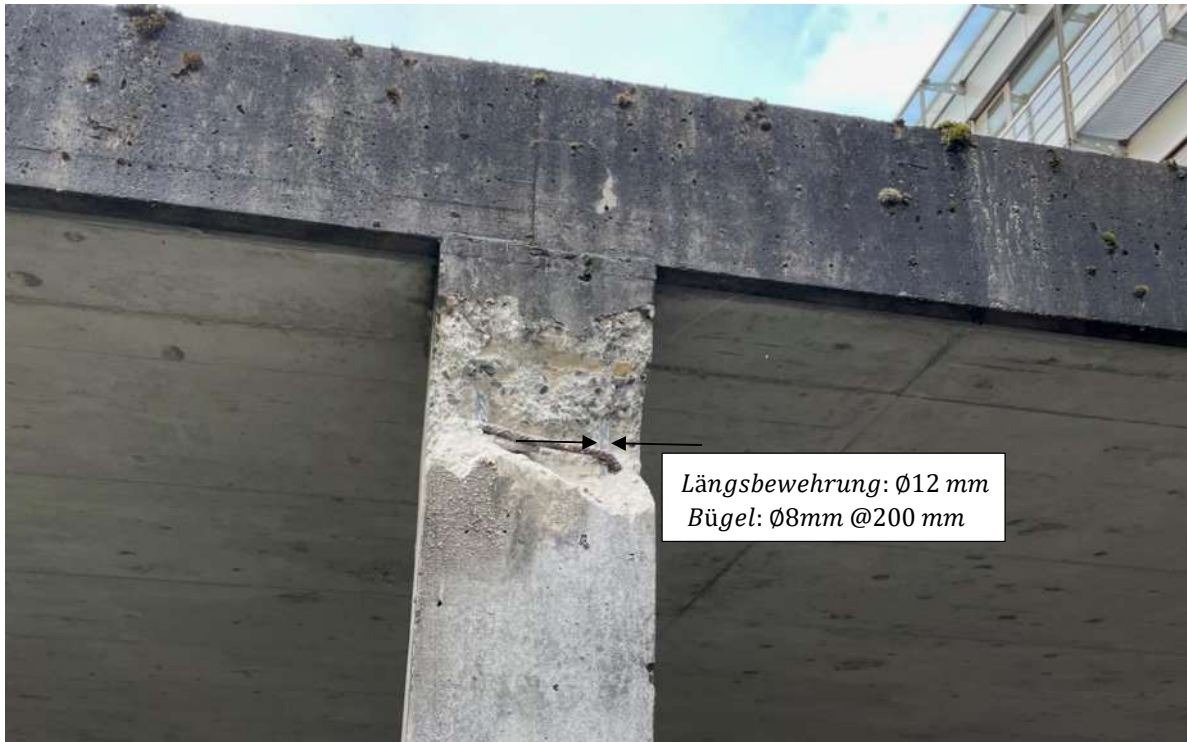
Abbildung 2: Bewehrung der Stütze im Kopfbereich
