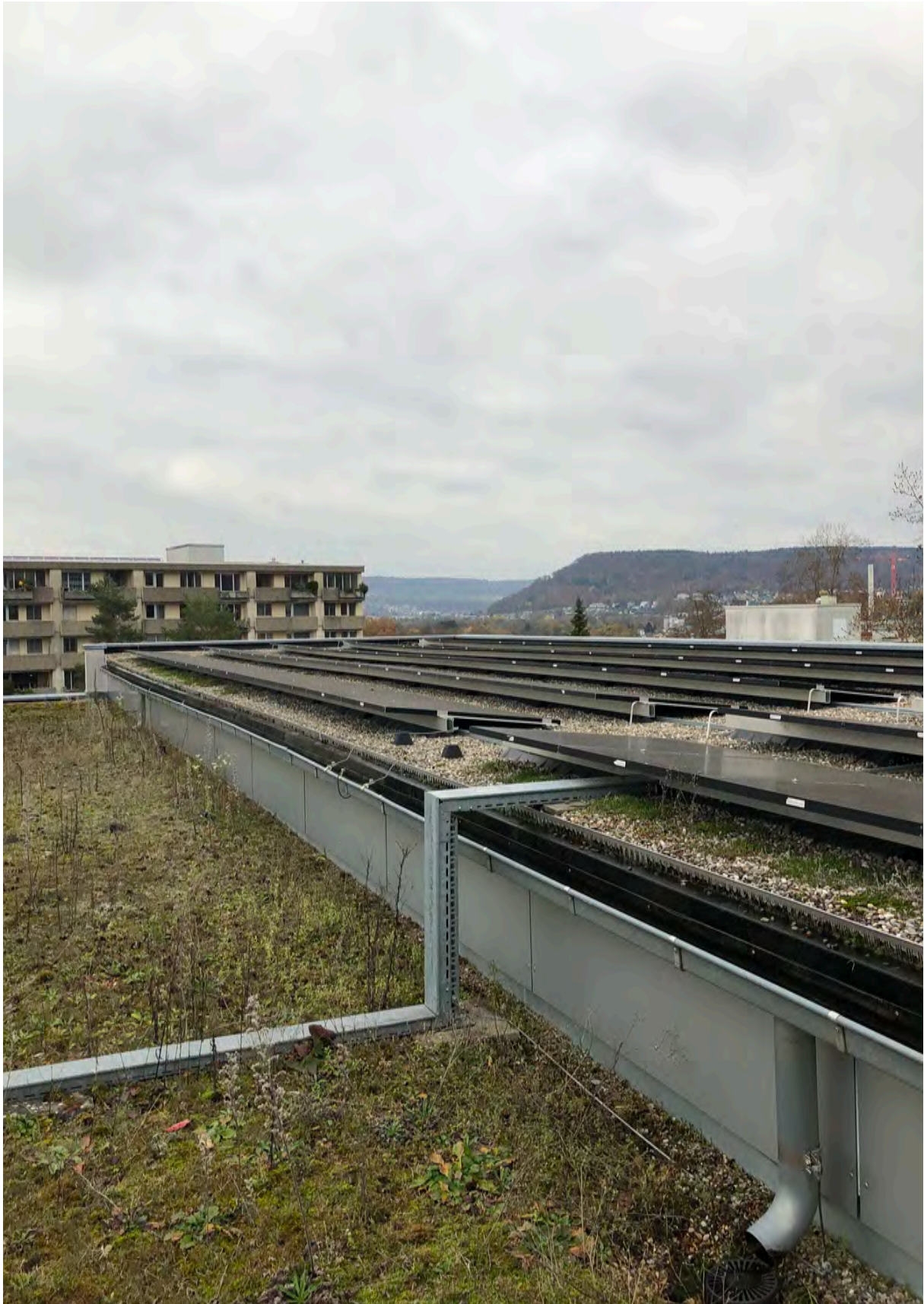
Foto Dach Bestand
