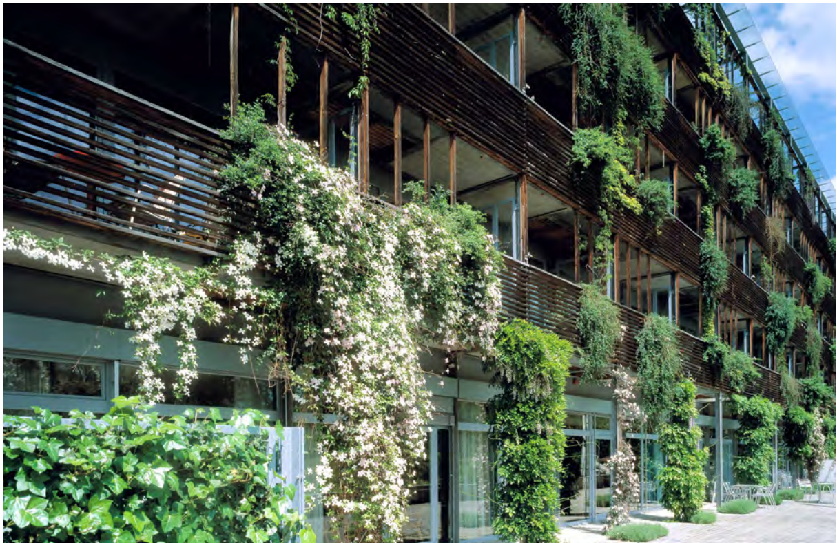
Referenzbild Altersheim Widen
