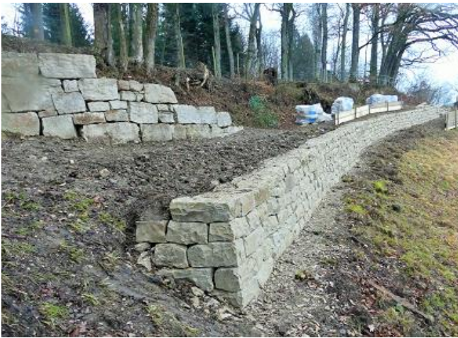
Bruggerberg neue Trockenmauern und Fachinen als Steinschlagschutz
