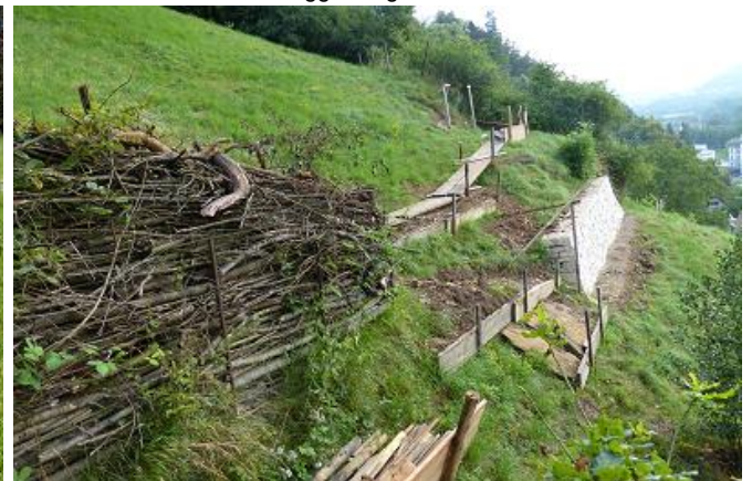
Bruggerberg – alte Rebmauern werden neu erstellt und dienen teilweise auch als Steinschlagschutz
