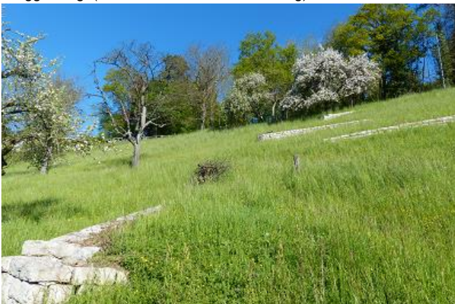
Bruggerberg – alte Rebmauern werden neu erstellt und dienen teilweise auch als Steinschlagschutz
