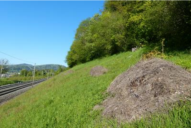
Bahnböschungen Umiken (Südlage)
