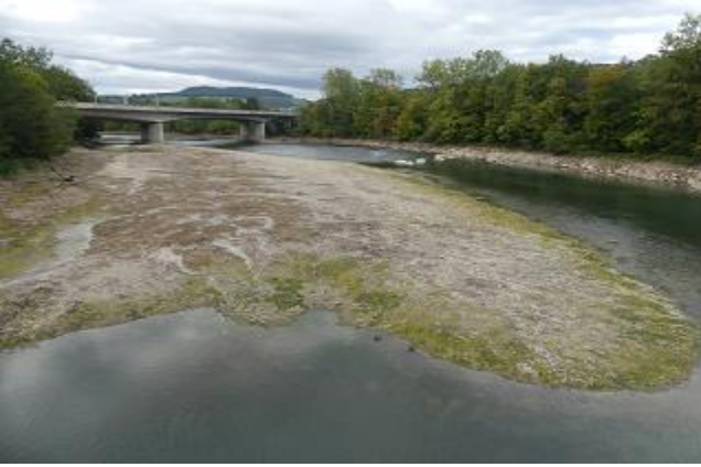
Dachwehr offen – Test der AXPO
