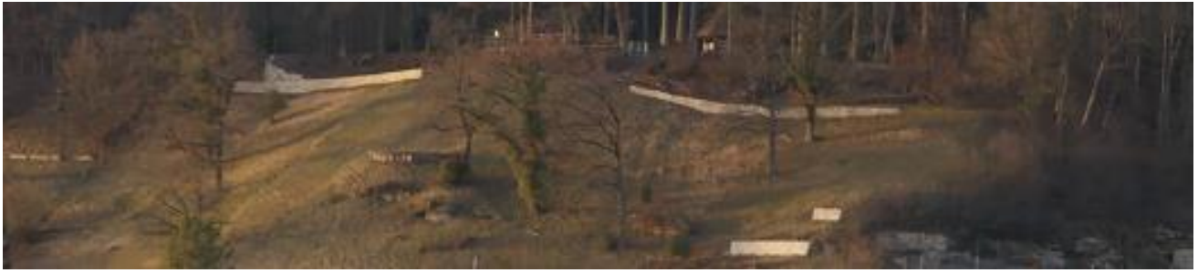
Neue Trockenmauern (Hexenplatz) im Abendlicht
