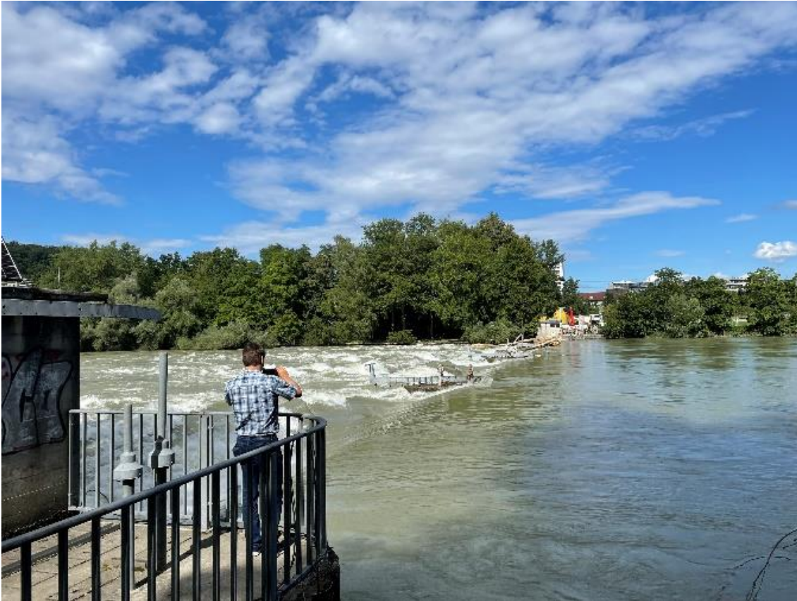
Abb. 2 Fotoaufnahme vom 2. August 2021, Aare im Bereich des bestehenden Dachwehrs (linkes Ufer)
