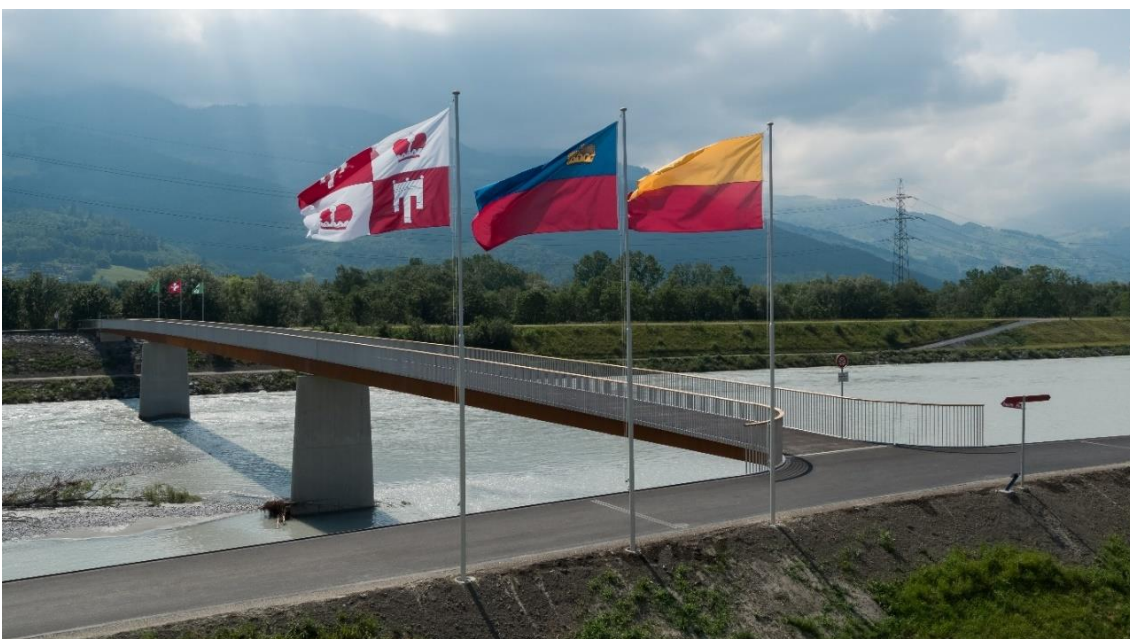
Abb. 11 Stahlkastenbrücke über den Rhein zwischen Buchs und Vaduz
