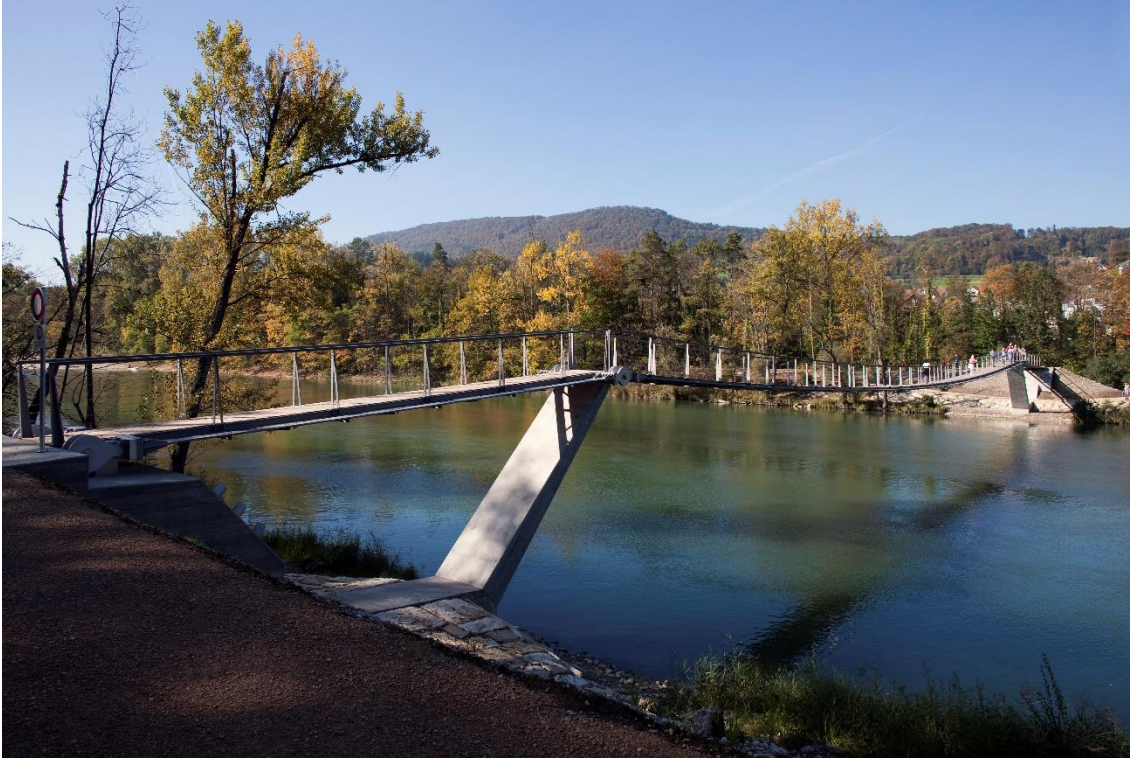
Abb. 10 Spannbandbrücke über die Aare in Rapperswil
