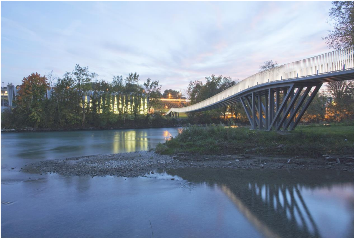
Abb. 12 Spannbandbrücke über die Aare zwischen Windisch und Brugg
