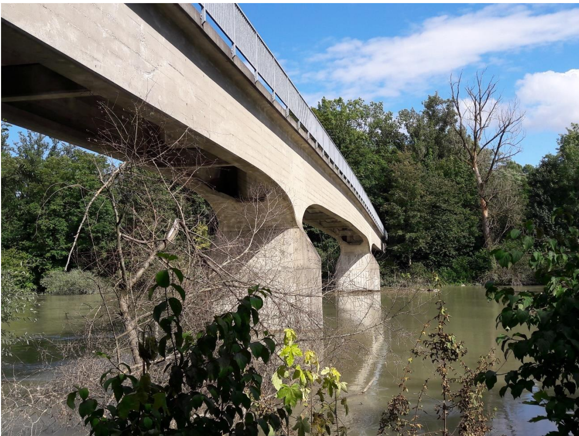
Abb. 3 Fotoaufnahme am 2. August 2021, Kanalbrücke gebaut 1957
