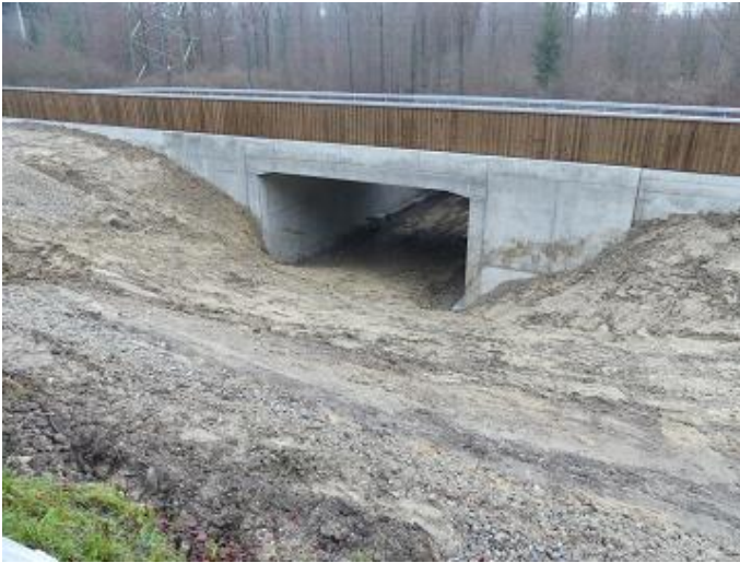
Eine Wildtierunterführung wird zwischen Brugg und Schinznach- Bad gebaut
