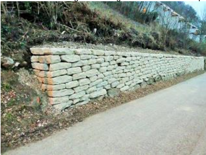
Sanierte Trockenmauer oberhalb Rinikersteig (CreaNatira). Versiegelte Flächen bei der Badi (Begrünungsplanung)
