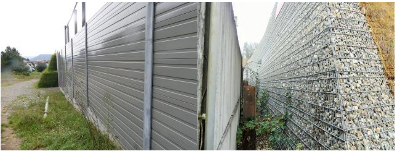
Lärmutz Bruggerberg Chilhalde: Baustopp – das Bächli ist immer noch unter Boden
