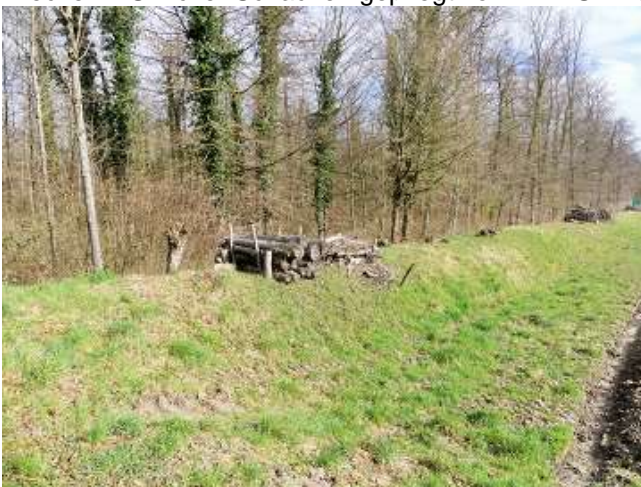
Strukturen Hochwasserschutzdamm Wildschachen
