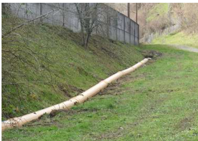
Eingedohlter Bach (längeres Provisorium) Chilhalde
