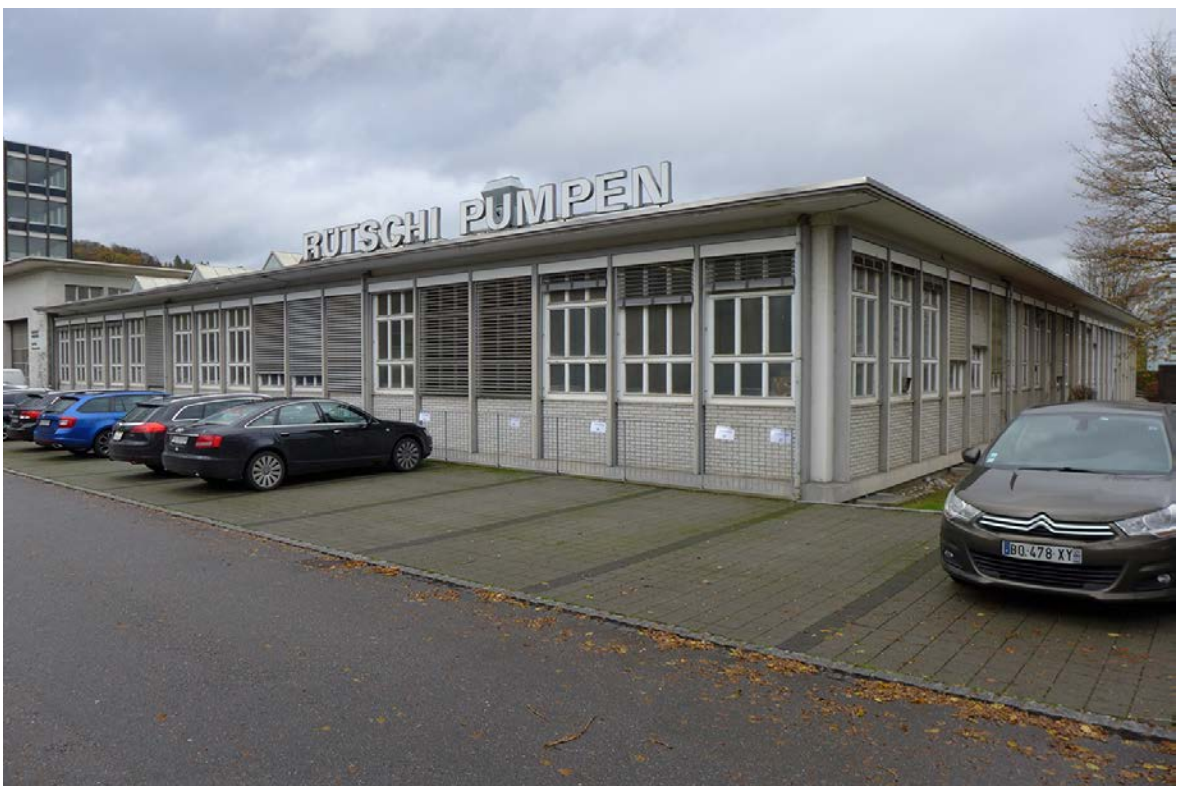
Abb. 33: Werkhalle Ausbautappe 2. (Fabian Furter 2016)
