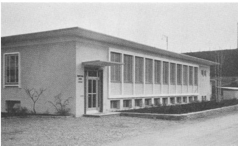
Abb. 05: Bürogebäude der ersten Bauetappe (1957 aufgestockt). (SBZ, Heft 17, 1952)
