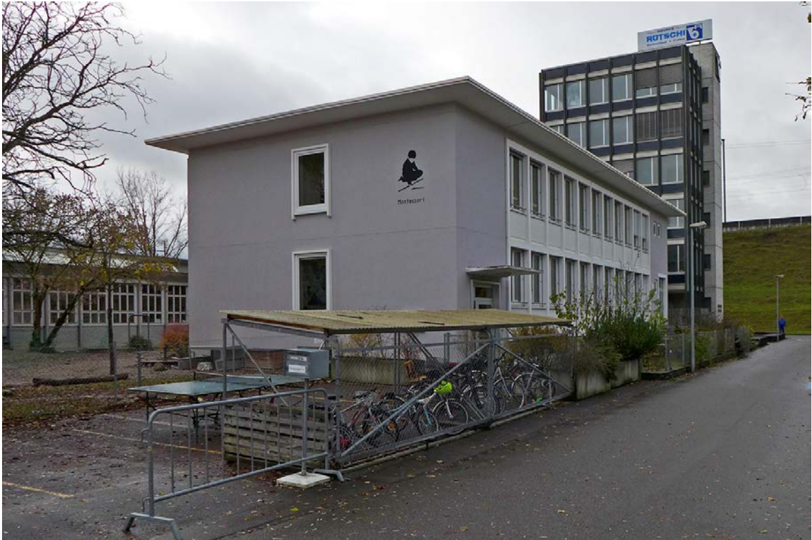
Abb. 36: Blick auf die beiden Verwaltungsgebäude an der Herzogstrasse. (Fabian Furter 2016)
