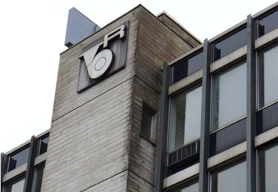
Abb. 31: «Rütschi-Tower» Fassadendetail mit ursprünglicher Werbetafel. (Fabian Furter 2016)
