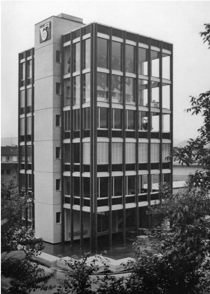
Abb. 16: Bürohaus nach Fertigstellung. Ansicht von Westen. (Privatarchiv Froelich)
