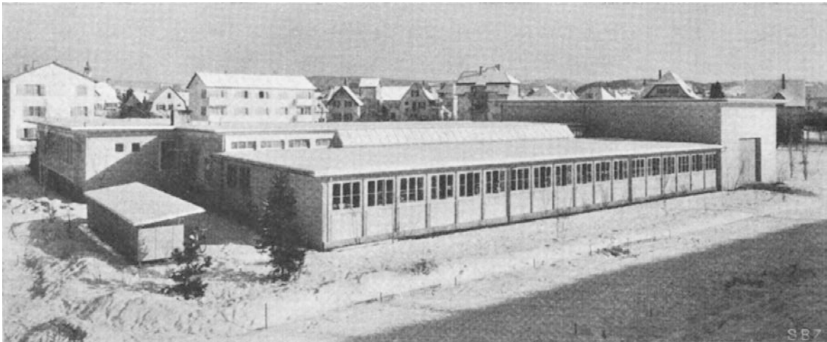
Abb. 02: Gesamtanlage Etappe 1 nach Fertigstellung vom Bahndamm. (SBZ, Heft 17, 1952)
