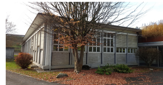
Fassade aussen Rastermass 1/3 der Grundstruktur >1.90 m
