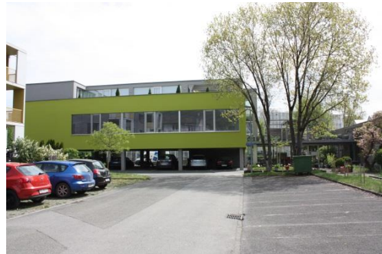
Nordwestlicher Anbau (Wohlfahrtsgebäude), Parz. 2401
