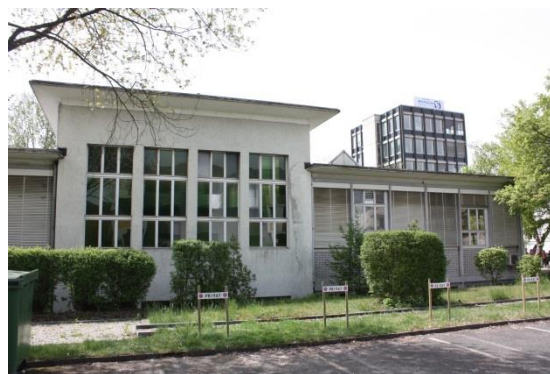
Rückseite der Fabrikbauten mit überhöhter, 6,5 m hoher Querhalle
