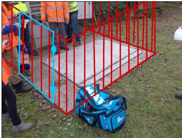
Abbildung 7: Nachrüsten eines Staketengeländers mit selbstschliessender Tür
