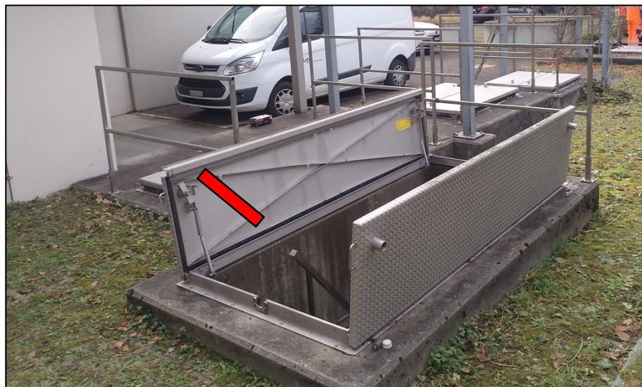
Abbildung 24: Verlängerung Handlauf auf einer Innenseite der Abdeckung
