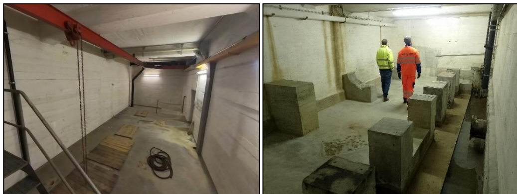
Abbildung 16: Alter Betriebsraum (links) und leerer Pumpenraum (rechts)
