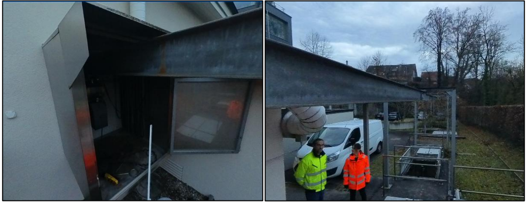
Abbildung 22: Krankasten und Kranbahn
