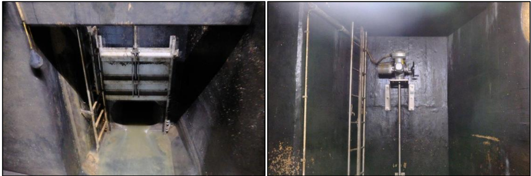
Abbildung 6: Zulauf mit SISTAG Schieber (links) und seinem Antrieb (rechts)
