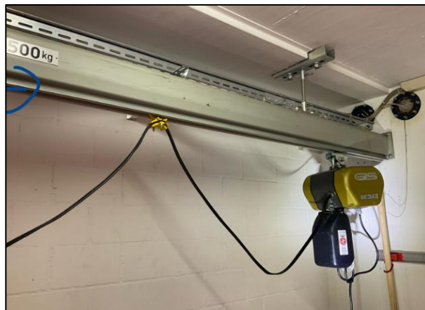
Abbildung 19: Kranbahn mit Elektrokettenzug
