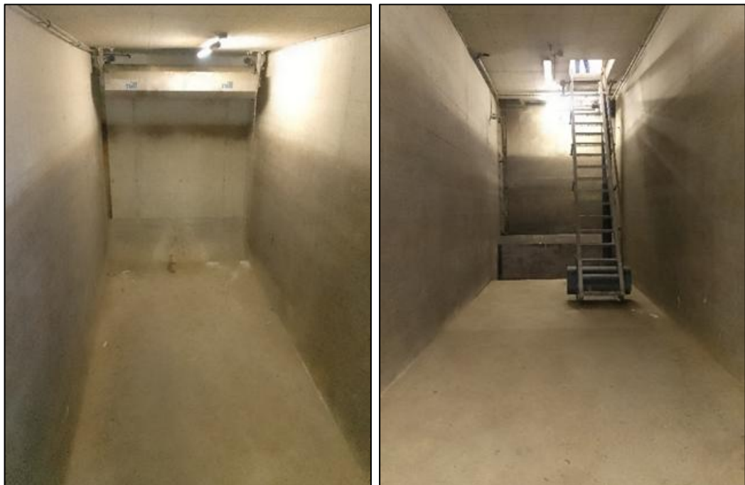
Abbildung 6: Fangbecken: Spülkippe (links), Einstiegstreppe und Zulaufüberlaufkante (rechts)
