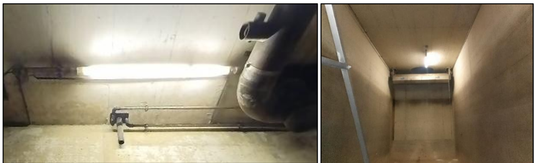
Abbildung 24: Beckenbeleuchtung (Ex-geschützt)
