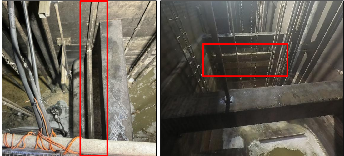
Abbildung 20: Tauchwand zwischen TW- und RW-Pumpensumpf
