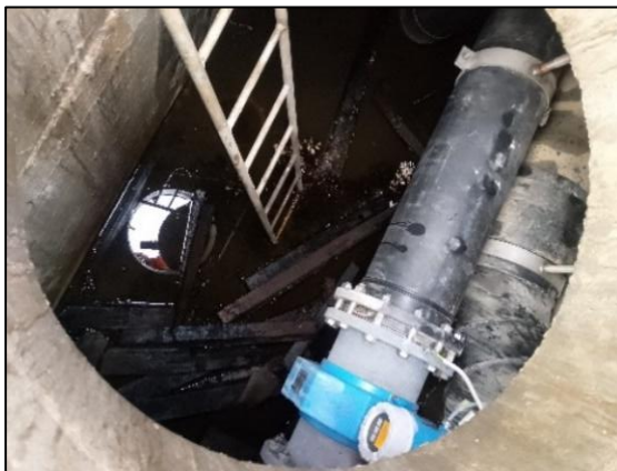
Abbildung 13: Blick in den Messschacht (links) und MID-Messung (rechts)
