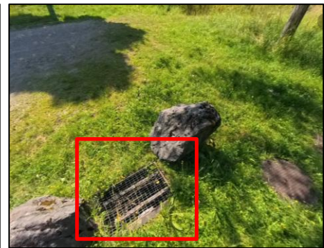
Abbildung 16: Ventilator für die Fortluft (links) und verrosteter Gitterrost über dem Lüftungsschacht für die Zuluft (rechts)
