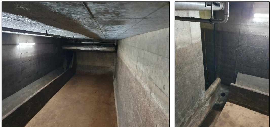
Abbildung 7: Fangbecken mit Trockenwetterrinne (links) und Einlauf in die Entleerrinne zum Pumpensumpf (rechts)
