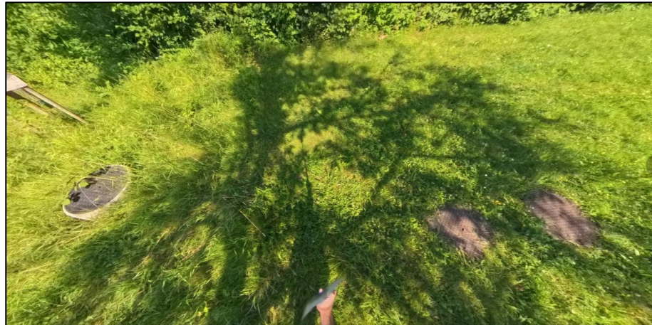
Abbildung 21: Die Abdeckung Schacht Zulaufkanal und Überlaufbauwerk
