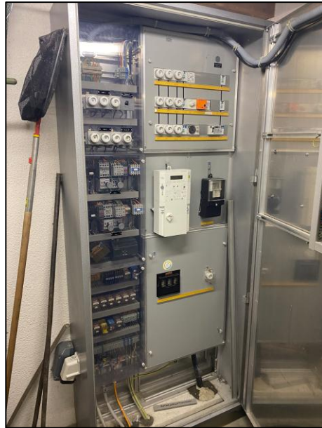
Abbildung 25: Innenansicht Schaltanlage
