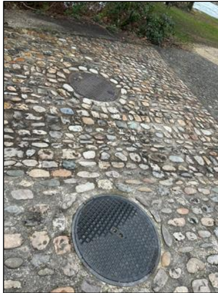
Abbildung 4: Situation vor Ort
