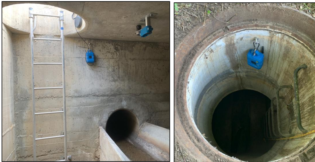
Abbildung 7: Beispiel einer Niveaumessung Entlastung und autarker Messkoffer mit Batterie
