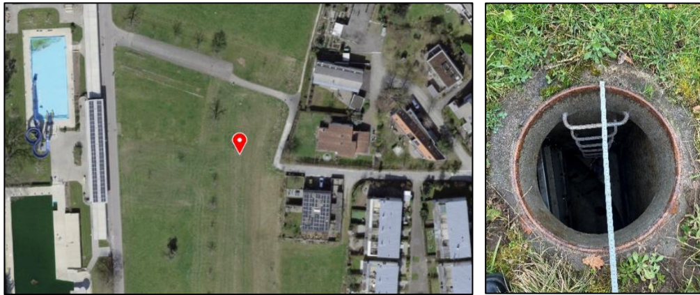
Abbildung 6: Luftbild und Einstiegsschacht RU 2 Brugg
