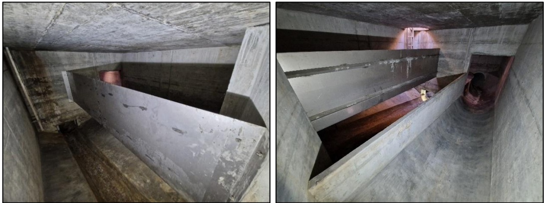
Abbildung 8: Regenüberlauf: Zulaufkanal (links) und Überlaufkante mit Entlastung (rechts)
