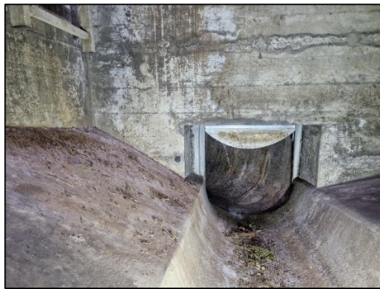
Abbildung 9: Schütz beim Auslauf
