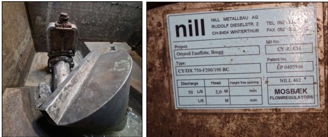
Abbildung 6: Wirbeldrossel des Drosselschachts(links) und ihr Typenschild (rechts)
