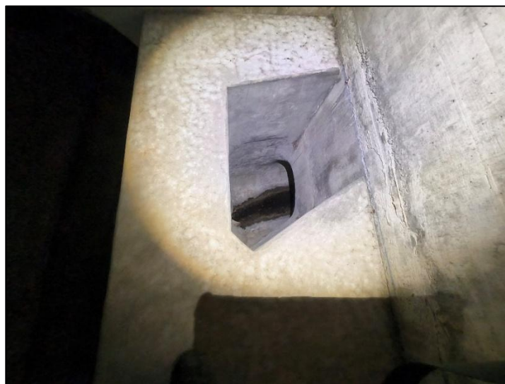
Abbildung 4: Bodenaussparung zur Entlastungsleitung
