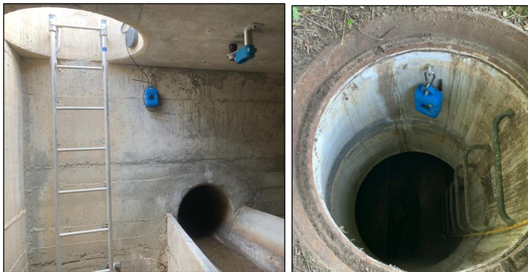
Abbildung 8: Beispiel einer Niveaumessung Entlastung und autarker Messkoffer mit Batterie
