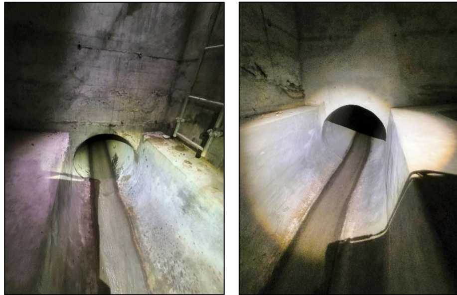
Abbildung 3: Einlauf (links) und Auslauf (rechts), RÜ F1030
