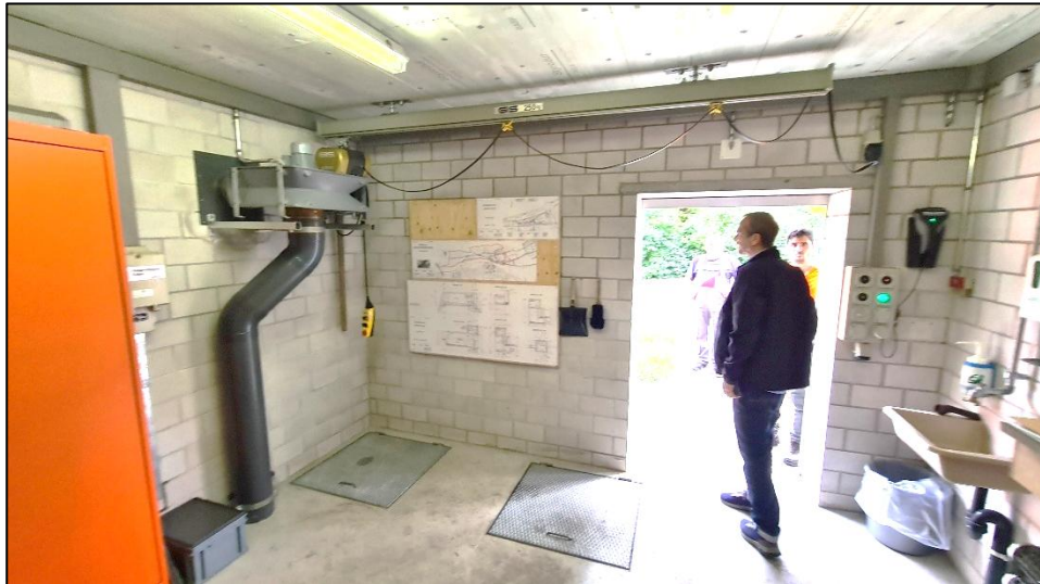
Abbildung 10: Hebeeinrichtung im Betriebsraum
