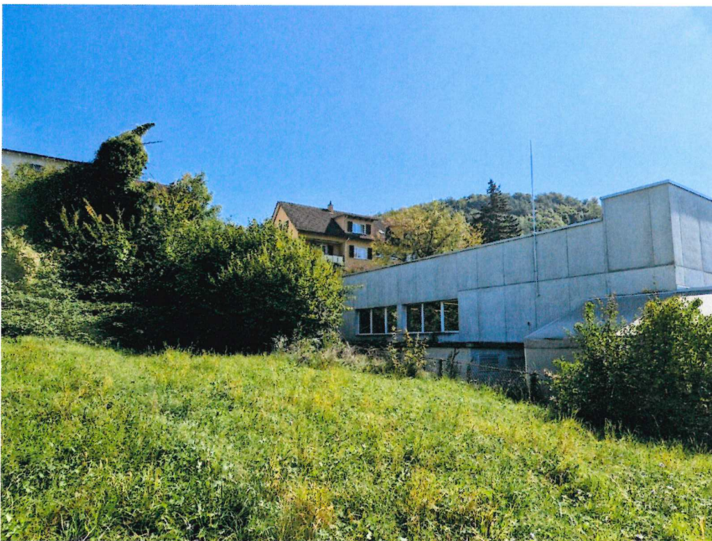
Gesamtansicht Mast und Befestigung, ohne Antenne
