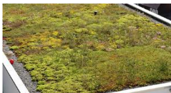
Flachdach extensiv begrünt.
