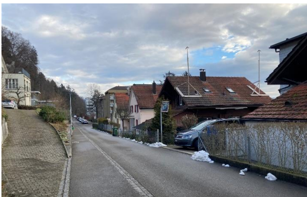
3. Rebmoosweg, Hausnr. 86 (rechts im Bild mit Bauvisieren), nach Nordosten blickend (Quelle: PLANAR)
