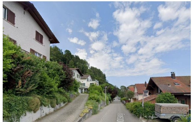
2. Rebmoosweg, Hausnr. 87 (links im Bild), nach Nordosten blickend (Quelle: Google)
