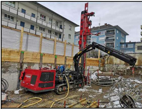
Pos. 1 - Bohrgerät Masse (LxBxH): 663 x 220 x 306cm
